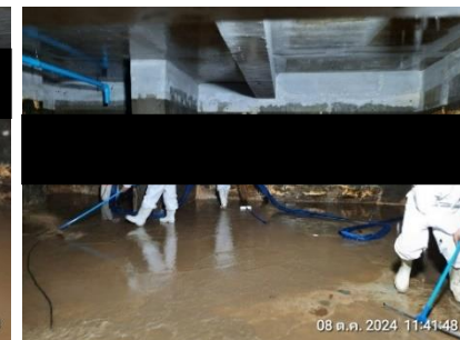
รูปที่ 2-36 เจ้าหน้าที่ล้างถังเก็บน้ำขึ้นใต้ดินและชั้นดาดฟ้า เมื่อวันที่ 8-9 ตุลาคม 2567 ในปี 2568 มีแผนในเดือนตุลาคม
